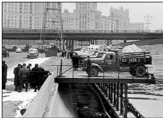
Рис. 4. Сброс снега с набережной Москва-реки со специальной эстакады
