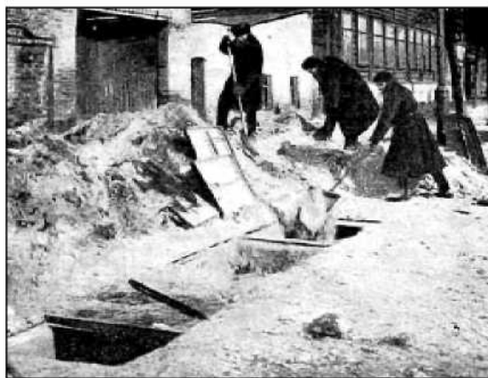
Рис. 2. Стационарная снеготаялка инженера Д.В. Домашнева при банях на ул. Библиотечная — люки для загрузки снега
